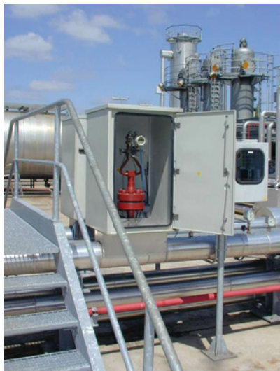
DF25HDD3 für verschmutztes Hochdruckerdgas hinter Bohrkopf
