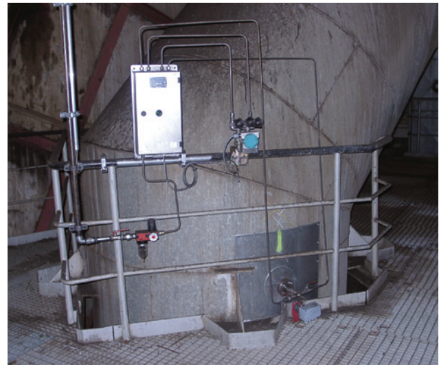
DF25 mit Spülsystem LSP für stark staubhaltige Verbrennungsluft nach LuVo
